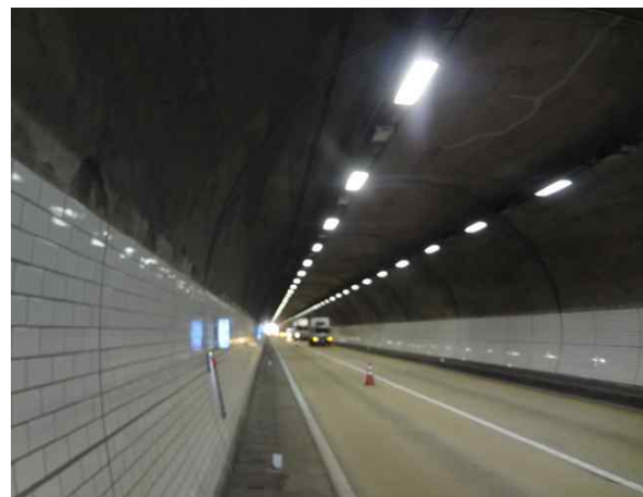
[하행선 내부 전경]
